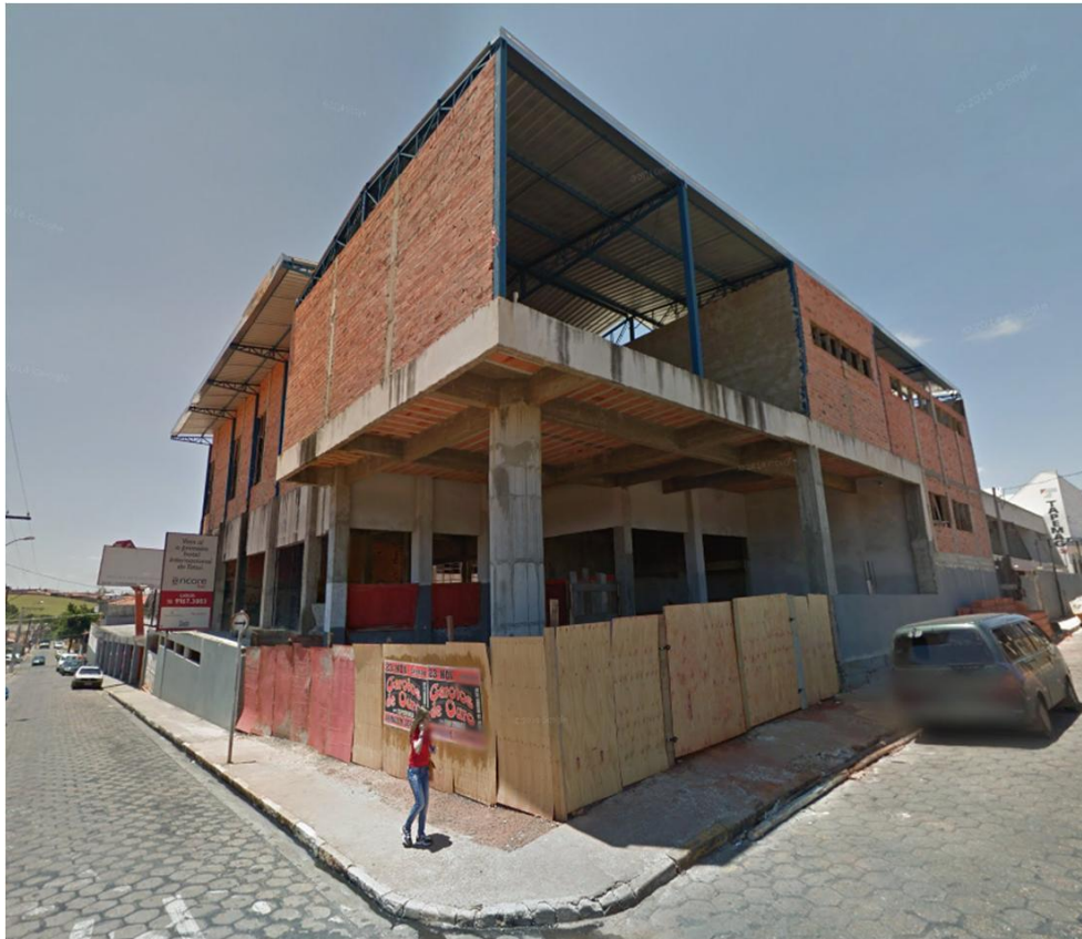
Figura 40 - Hotel em construção - Tatuí, SP.
